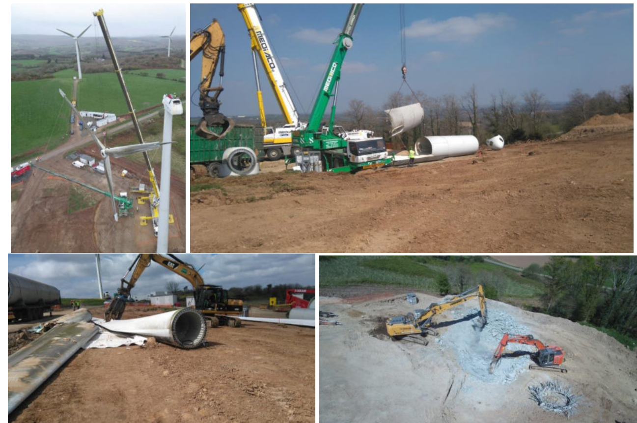
Figure 28: démantèlement du parc éolien de Plouyé (démontage de l'éolienne, cisailage de la pale, destruction de la fondation)
