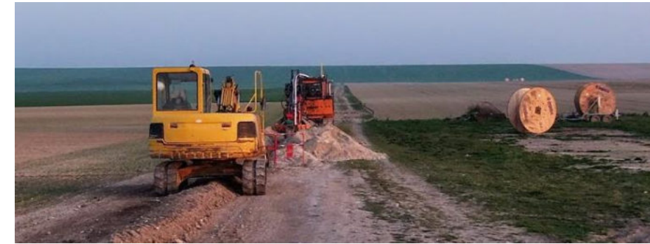
Figure 22 d'un exemple de travaux pour l'installation du raccordement enterré
