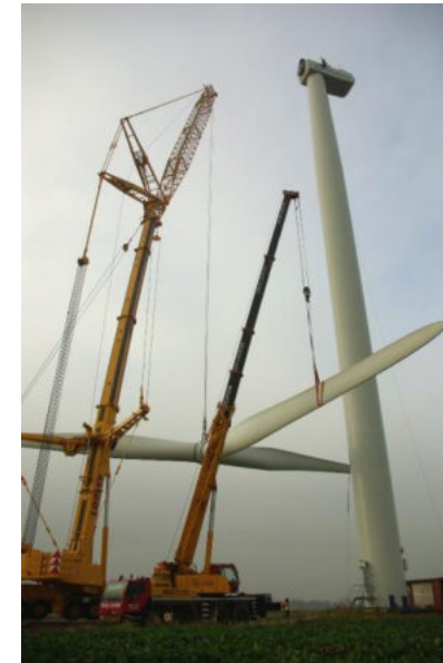
Figure 23 d'exemple de séquences d'assemblage d'une éolienne
